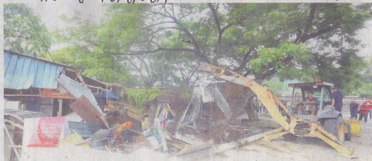
KERJA-KERJA merobohkan premis setinggalan di persimpangan selekoh Kampung Pasir, Ukay Perdana, Hulu Klang, Selangor, berjalan lancar tanpa sebarang insiden kelmarin. -UTUSAN/ROY AZIS ABD. AZIZ
