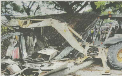
Operasi merobohkan premis sedang dijalankan.
