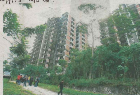
DUA blok kondominium Highland Towers ini akan dirobohkan bagi memberi laluan kepada projek pembinaan taman rekreasi. - Gambar hiasan
