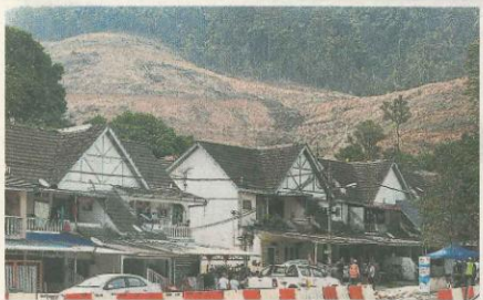
■山上的黄泥随着雨水顺势而下，冲向莲花1/2路民宅。
