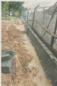
■部分工地设有砖墙，避免水源流入。
