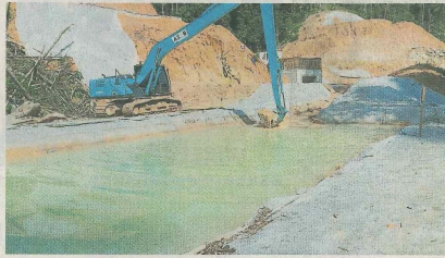
■大道公司采取多项安全措施，包括工地周围都设有蓄水池。
