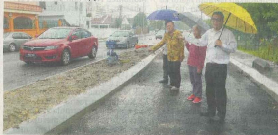
BEN LIEW POK BOON (kanan) bersama penduduk menunjukkan struktur utiliti paip di Pandan Perdana, Kuala Lumpur, baru-baru ini. - UTUSAN / MUHAMMAD SYAFIQ ZULKEFLE (PELATIH UITM)
