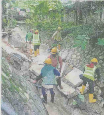
Kerja pembersihan sedang dijalankan di lokasi kejadian.
