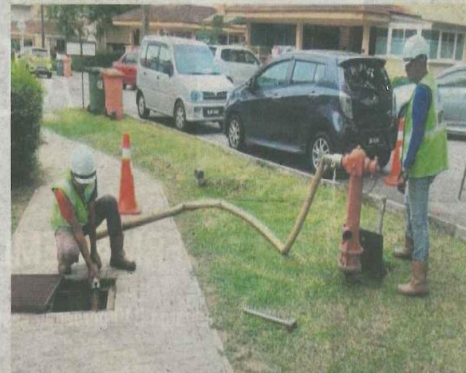
DUA petugas Air Selangor melakukan kerja-kerja mencuci sistem perpaipan di sekitar negeri itu baru-baru ini.
