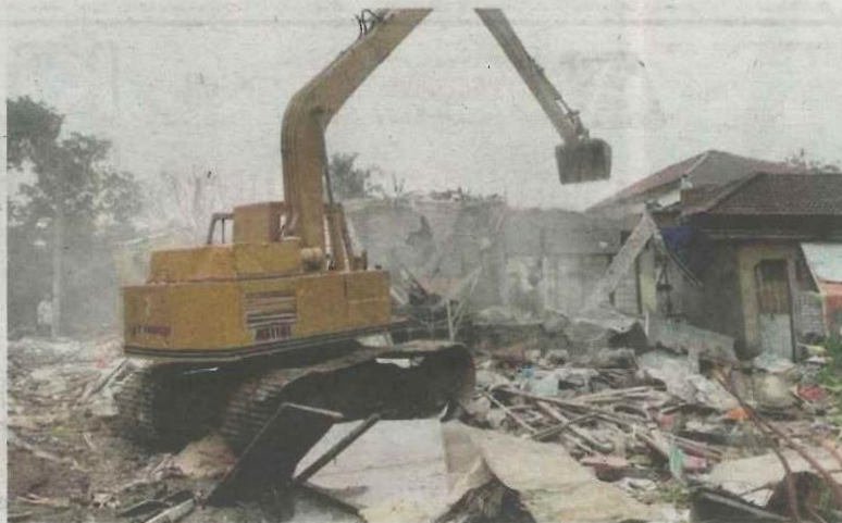
JENTOLAK digunakan untuk merobohkan rumah-rumah penduduk Paya Jaras Hilir, Sungai Buloh kerana status pembinaan rumah tersebut di atas tanah rezab sungai.
