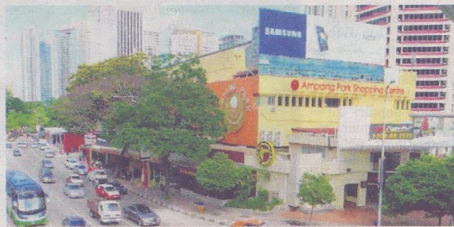
KERJA-KERJA merobohkan pusat beli-belah Ampang Park ini boleh diteruskan selepas Mahkamah Rayuan Putrajaya semalam menolak rayuan 39 pemilik strata dan penyewa di situ.
